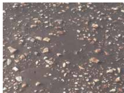
Поверхность дороги, обработанная 30 часов назад профилактическим средством «Антипыль» марки Д (абсорбент). На дорожной поверхности сохраняется влага и связывается пыль
